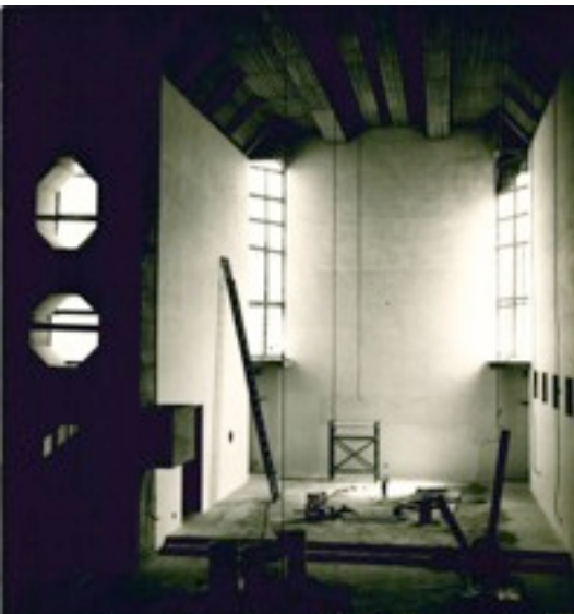
Foto di cantiere. Immagine ©ASFi
