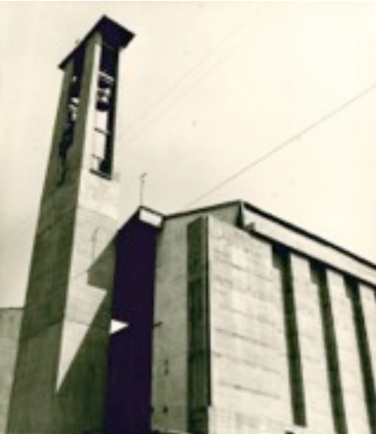
Foto di cantiere. Immagine ©ASFi
