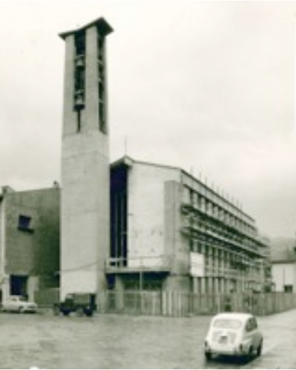
Foto di cantiere. Immagine ©ASFi
